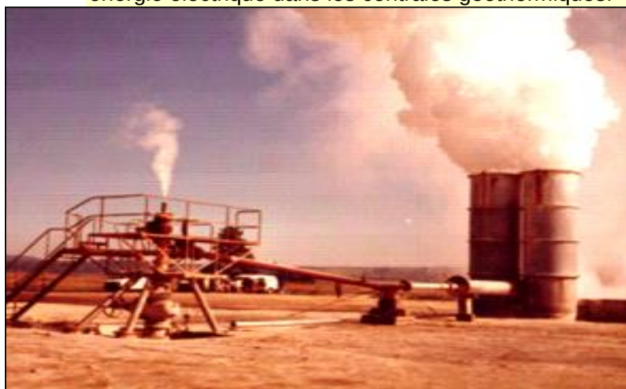
Test de production sur le forage Asal3 produisant un réservoir de haute enthalpie à 262°C. Evacuation de la vapeur par le séparateur atmosphérique
